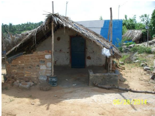
Hus før reparasjon – ikke rare greiene å bo i!
