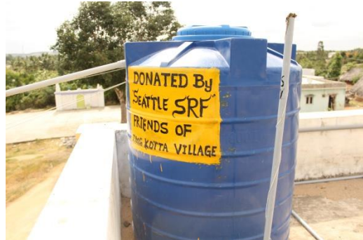
Ny vanntank på taket til en skole som er rehabilitert av oss
